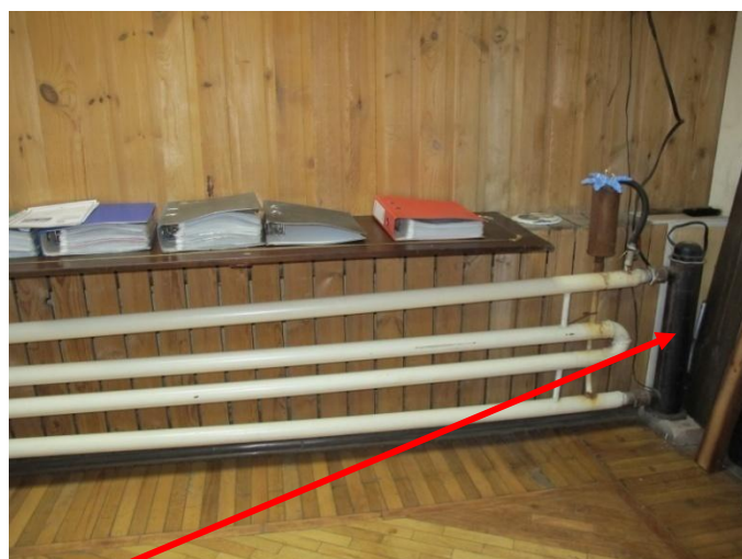
Интерьеры, помещение 15. Электрический котёл системы теплоснабжения.
