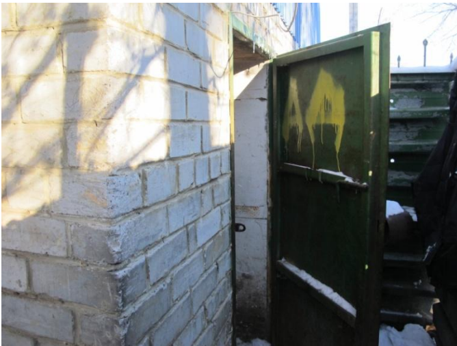
Юго-Западный фасад. Вход в помещения 1, 2.
