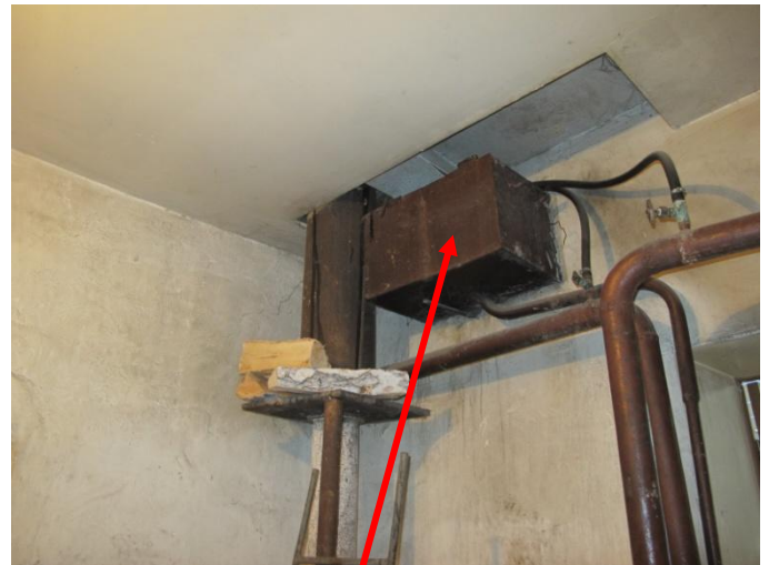
Интерьеры, помещение 17. Котёл дровяной. Расширительный бак.
