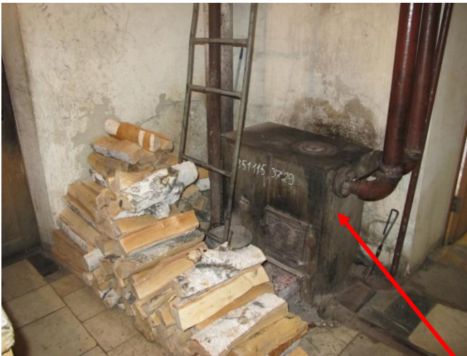
Интерьеры, помещение 17. Котёл дровяной. Расширительный бак.
