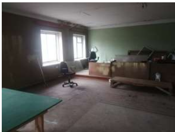
Фото 9. Нежилое здание (административное здание), общей площадью 400,5 кв.м.
