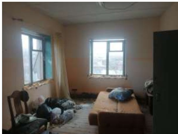
Фото 10. Нежилое здание (административное здание), общей площадью 400,5 кв.м.
